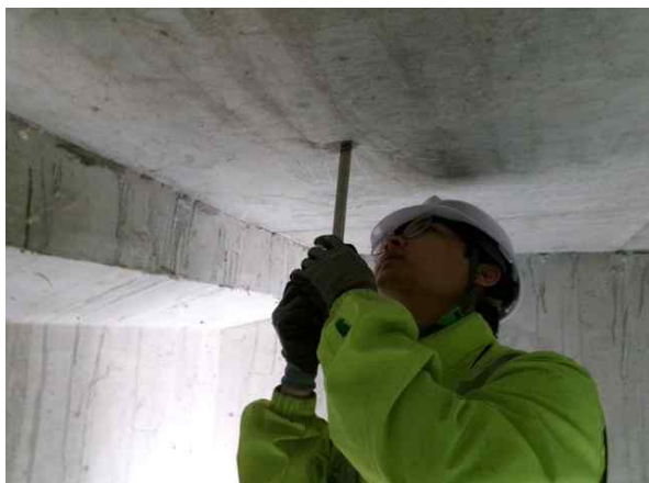
탄산화깊이 측정 현황
